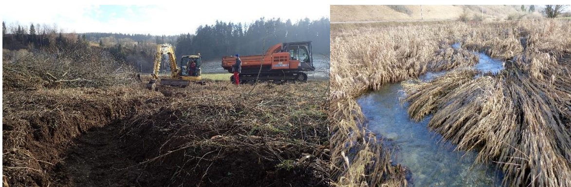
Figure 1 Méandres créés sur le secteur 1 dès novembre 2018
