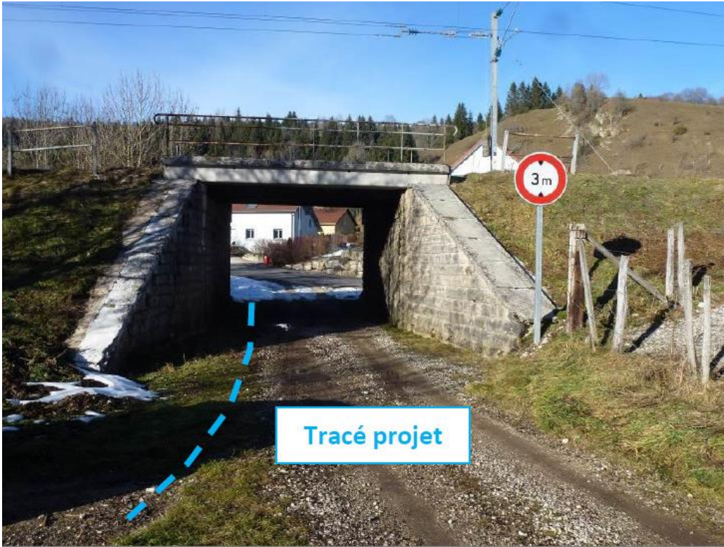
Figure 4 Pont SNCF sous lequel sera installé le franchissement
