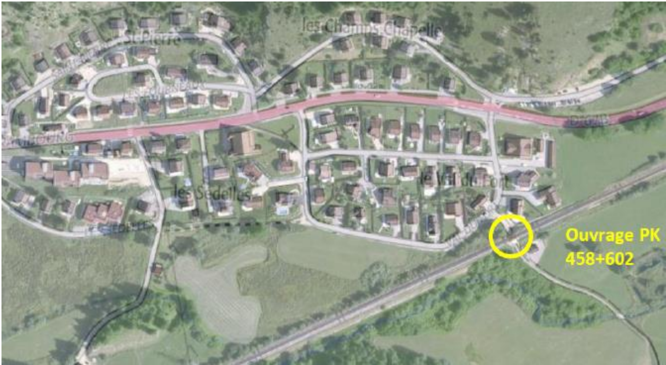
Figure 3 Site d'implantation de l'ouvrage
