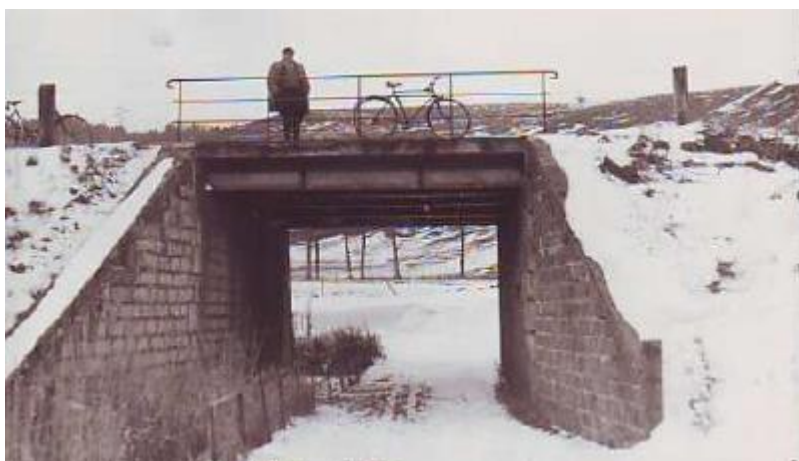
Figure 2 Photo non datée côté droit dans le sens de la ligne (Frasne - Verrières de Joux)
