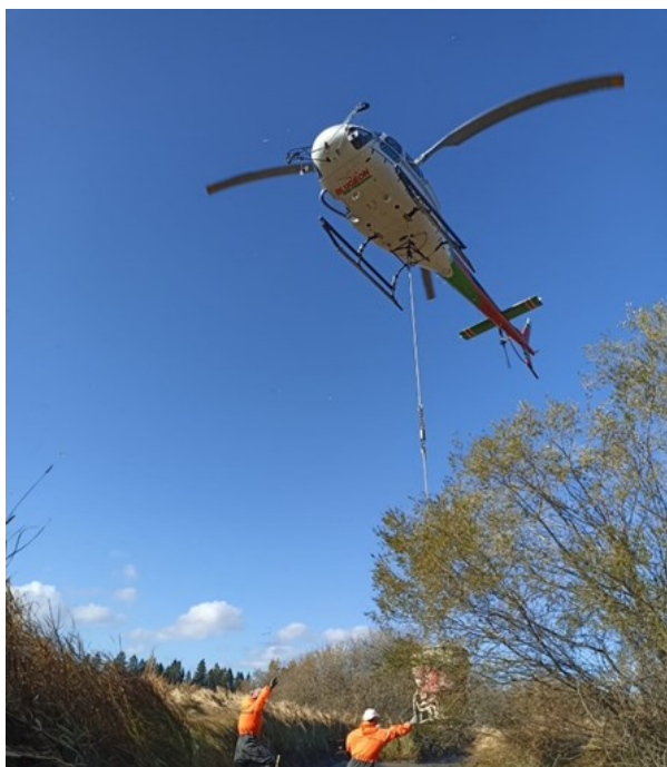
Apport de matériaux par hélicoptage
