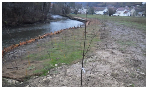
9 décembre 2020 : après travaux
