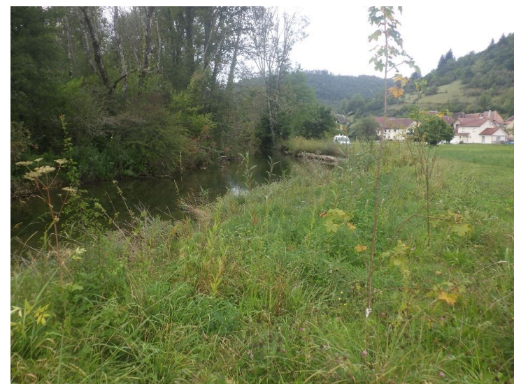
9 septembre 2021 : 8 mois après travaux
