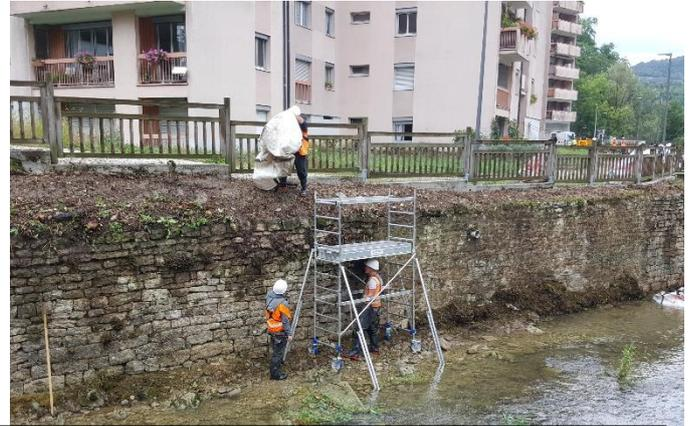
Coupe de la végétation et nettoyage des maçonneries rivaines avant rejointoiment et reprise
