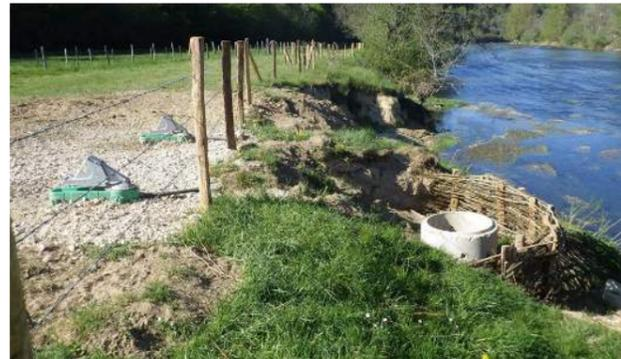
Photo prise au cours des travaux : point d'abreuvement par pompes à museaux
