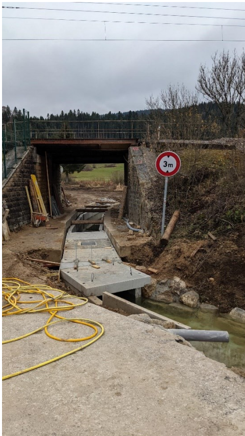
Franchissement de la voie SNCF en cours de construction
