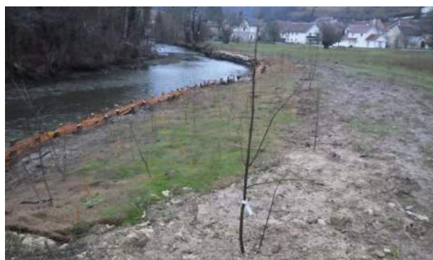
9 décembre 2020 : après travaux
