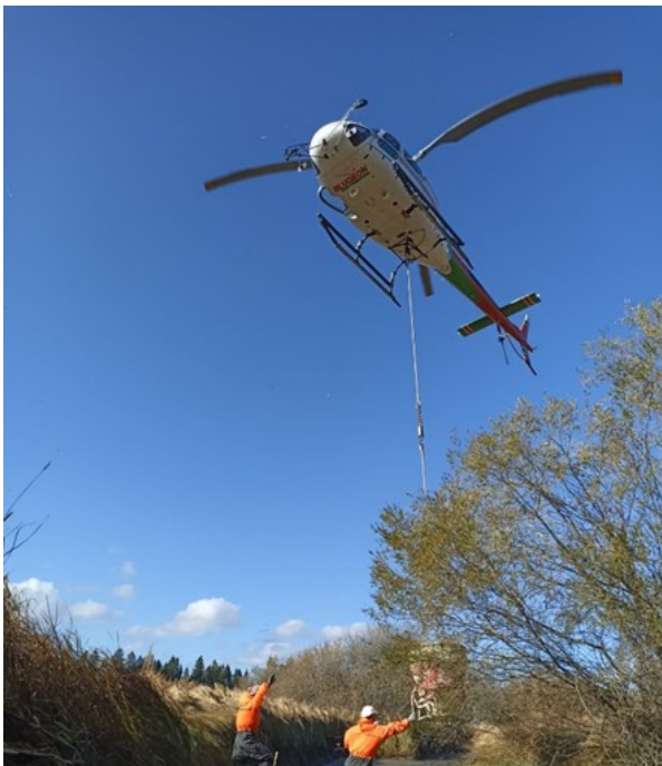
Apport de matériaux par hélicoptage
