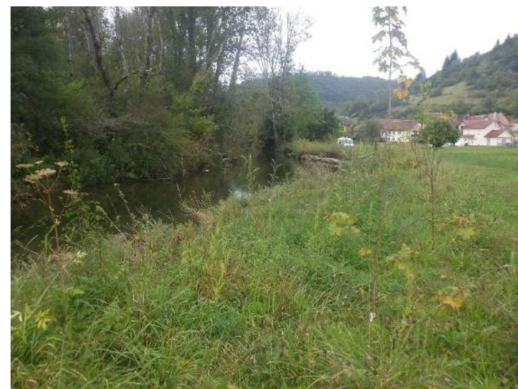
9 septembre 2021 : 8 mois après travaux
