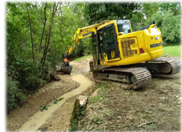
@Jérémy NICOLET – EPAGE HDHL – Terrassement des berges et du profil en long par une pelleteuse adaptée aux milieux humides
